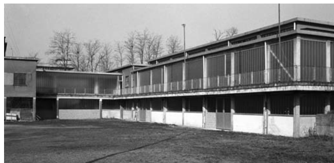
La nuova palestra inaugurata alla fine del 1978 a seguito del restauro della Colonia Elioterapica.
