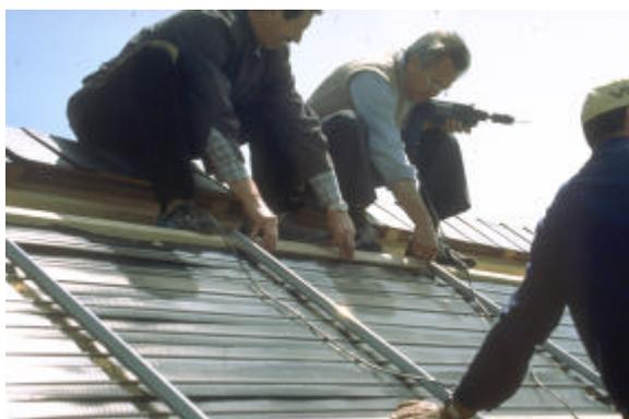
*Figura 5.8: Collettore con strisce di assorbimento ad andamento orizzontale.*
