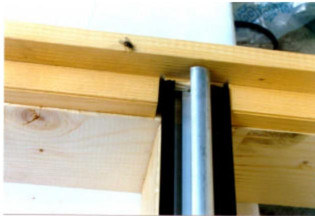
*Figura 5.10: Profili di alluminio a T per l'appoggio del vetro con inseriti i gommini portavetro.*
