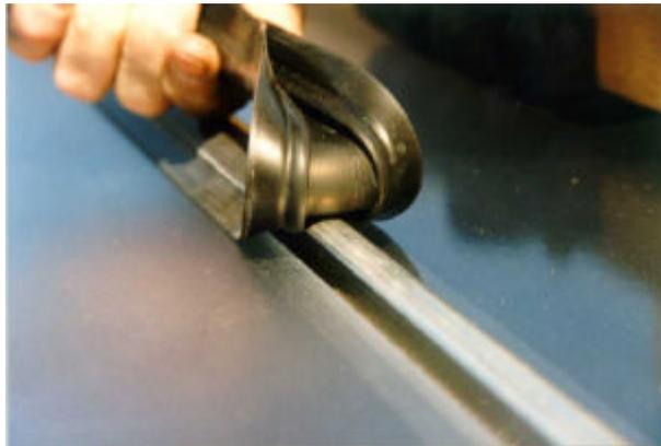
*Figura 5.15: Applicazione della guarnizione di copertura.*
